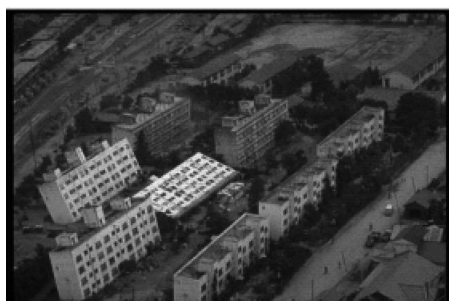
图 1.6 日本新潟地震液化
